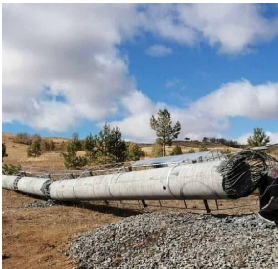
Рисунок 2. Последствия падения вышки сотовой связи
