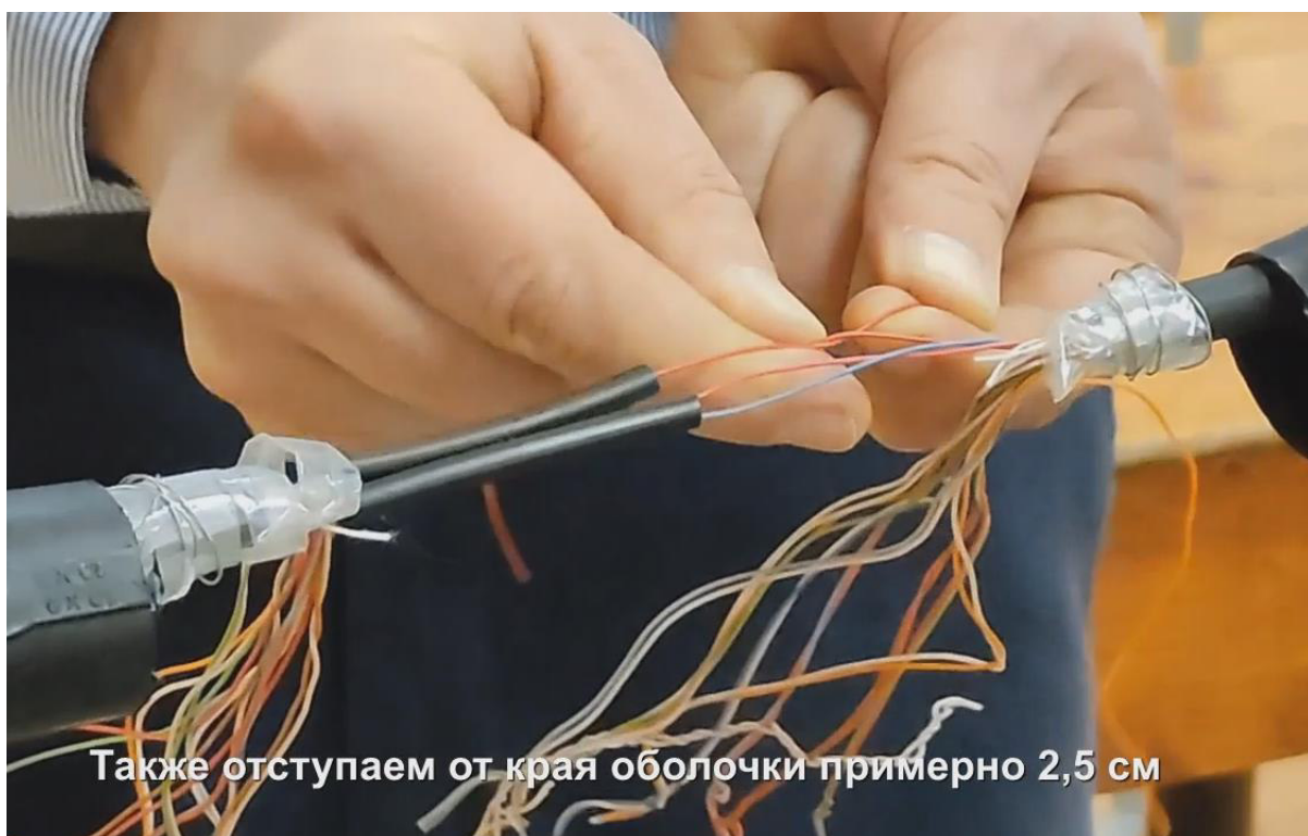
Рис. 2 Видеофрагмент соединения многопарных кабелей методом скрутки
