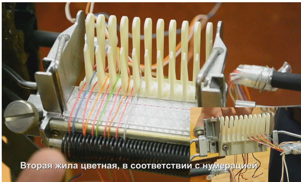
Рис. 3 Видеофрагмент соединения многопарных кабелей врезного контакта
